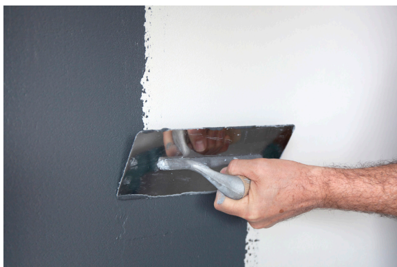
Figura 30) Applicazione manuale intonaco finitura
