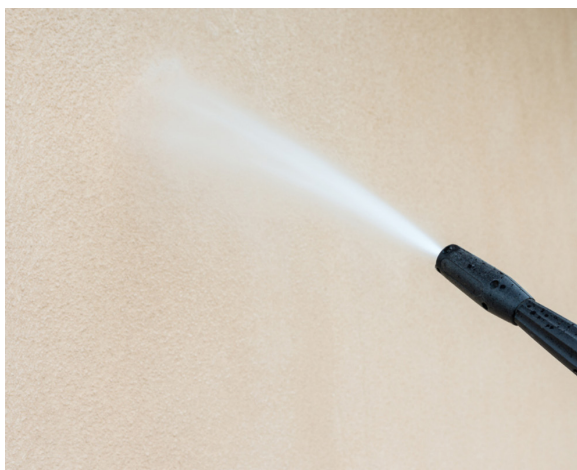
Figura 1) Lavaggio del supporto
