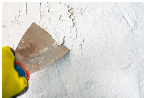
Figura 2) Rimozione superficie friabile
