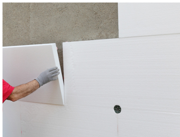
Figura 17) Corretta applicazione dei pannelli
