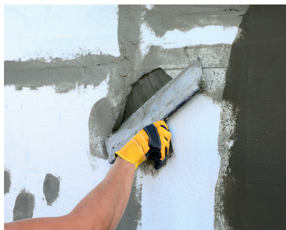
Figura 27) Applicazione intonaco
