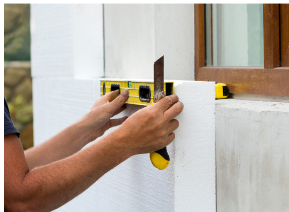
Figura 19) Rivestimento elementi sporgenti
