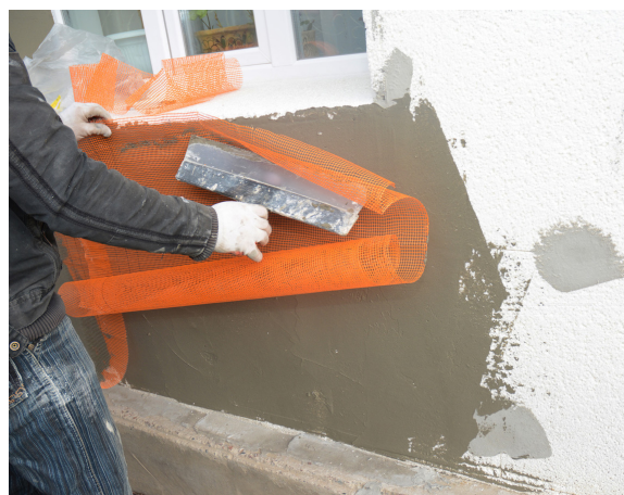
Figura 28) Rete d'armatura
